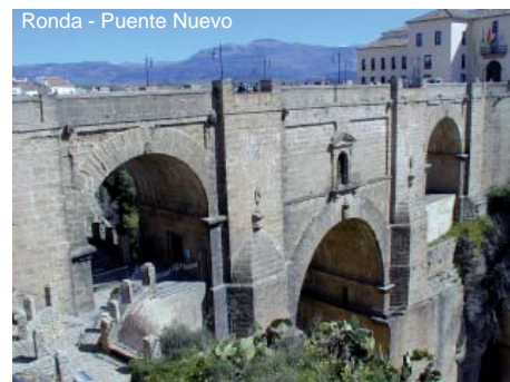
Ronda - Puente Nuevo
